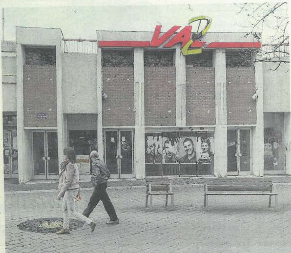
La démolition de la galerie Val2, désertée de ses commerces, devrait intervenir au premier semestre 2017.
